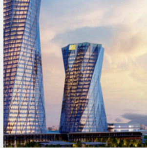
İFM- VakıfBank Genel Müdürlük Hizmet Binası ve Tesisleri B Blok
